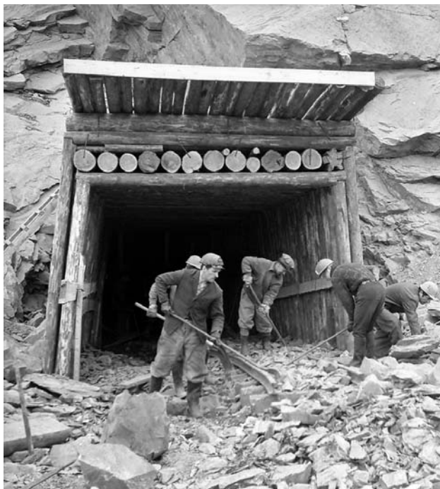
Рис. 1.5. Начало строительства рудника Северный, 1972 г. (архив пресс-службы ОАО «Кольская ГМК»).
